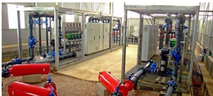
*Cabeçal- Filtros de malha, sistema de bombagem e de fertirrega*
