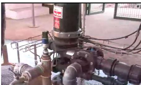
Quando a **limpeza é manual**, os filtros devem ser limpos quando a diferença de pressão entre a entrada e a saída é superior a 0.5 bar;
